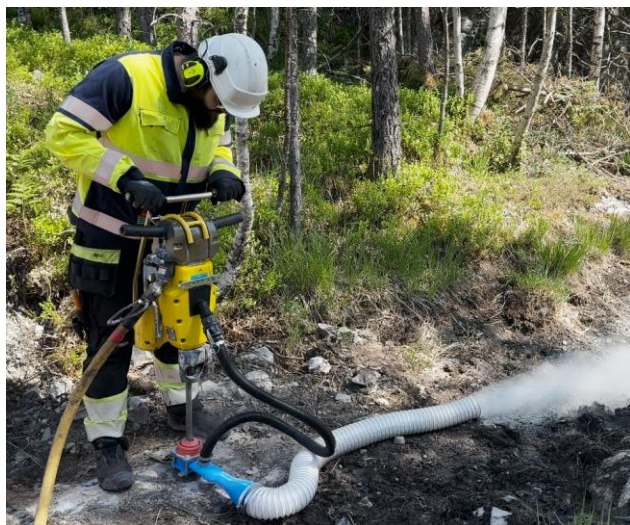
Bilde: Boring med Atlas Copco SRD 25 med påhengt vektlodd modifisert med håndtak, samt støvsuger.
